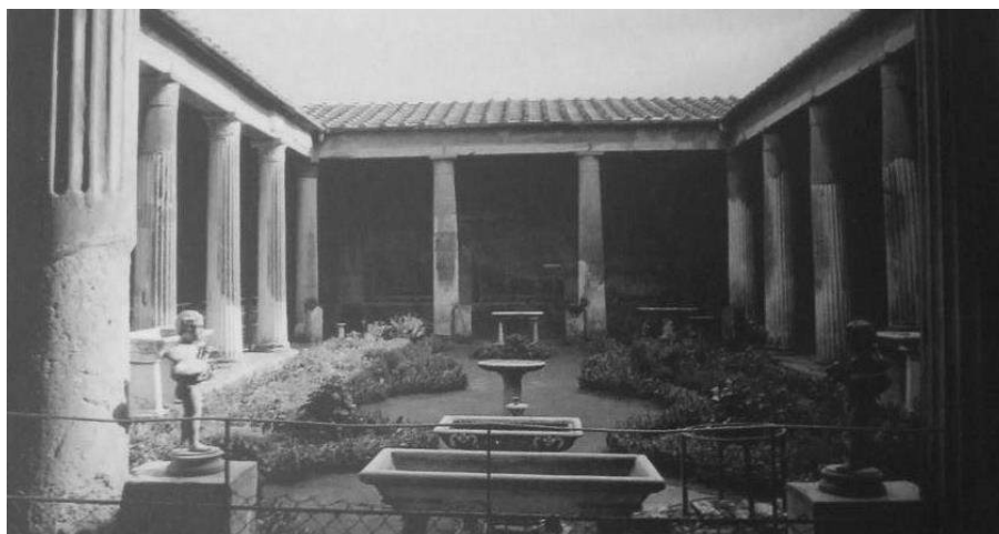
Будинок Ветті в Помпеї
