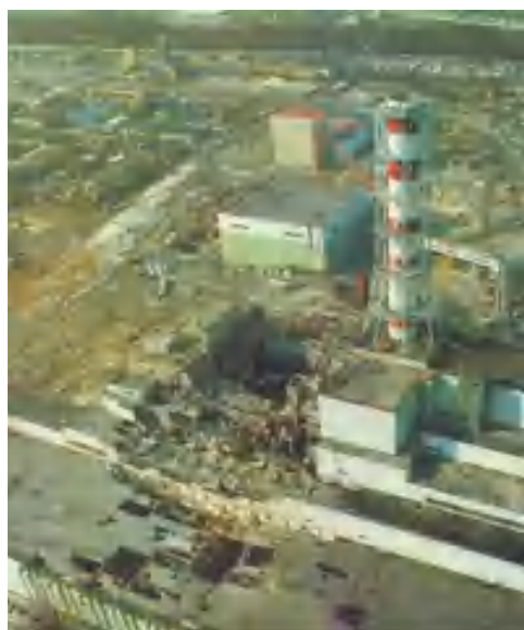
↑ Зруйнований четвертий реактор ЧАЕС
